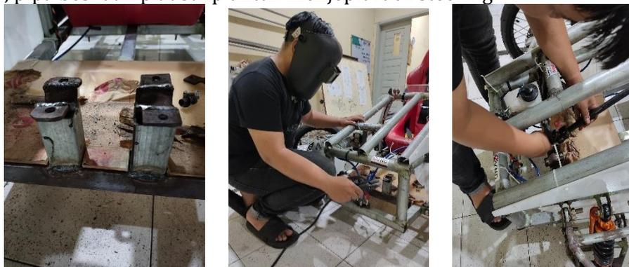
Gambar 2 pembuatan bracket rack steering dan pemasangan rack steering
