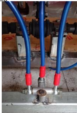
Gambar 5 Pembuatan bracket dan pemasangan housing cabang
