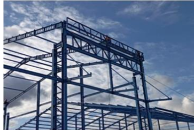
Pemasangan Canopy Ramp Bays
